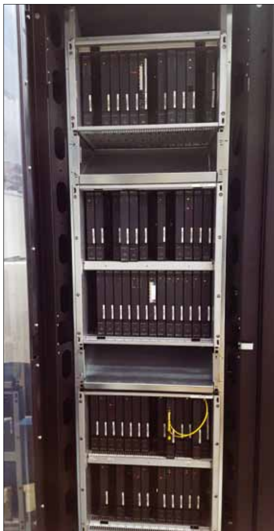
Detajl telefonske centrale
